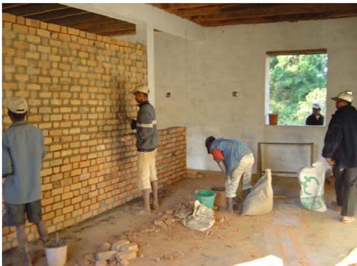
La construction d'un mur pour séparer 2 des 4 classes. Une porte au fond permettra de rentrer dans la 2<sup>ème</sup> classe, les récréations étant en même temps.
