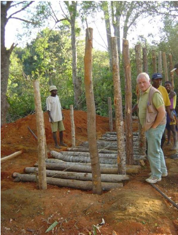
Le vécé gasy (WC malgache) est constitué d'un grand trou de plus de 4 m de profondeur, avec un plancher ajouré.
