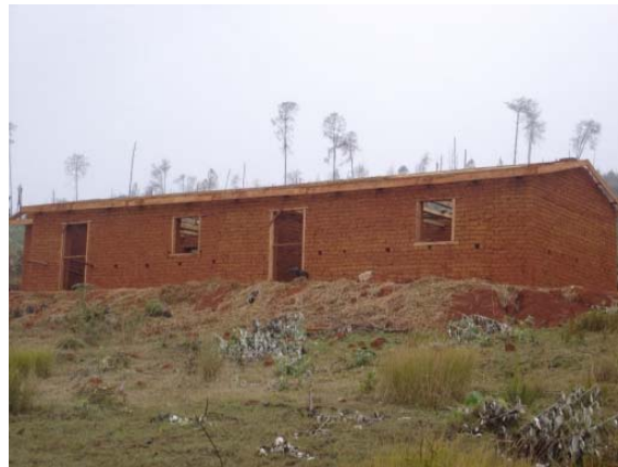
Le futur bâtiment pour les 5 e et les 4 e encore en construction le 29 juin 06.
