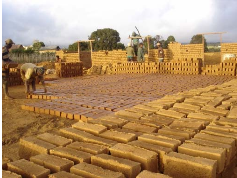
Elévation des murs du collège EPIS , le 11 juillet 06
